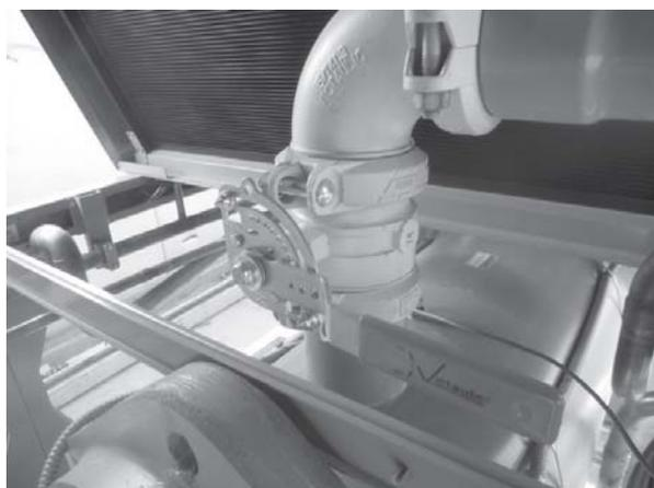
**Fig. 67 — Válvula bloqueio da sucção – fechada**
